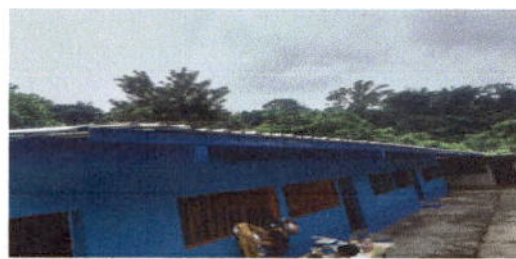
Foto 6: cubierta de lámina
