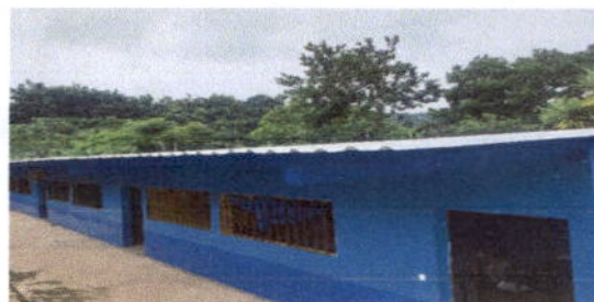
Foto 2: cubierta de lámina módulo 2
