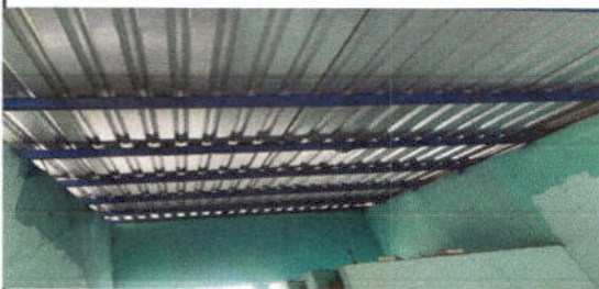
Foto 5: mantenimiento de estructura de soporte de metal
