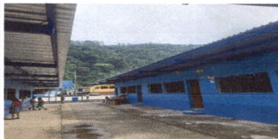
Foto 4: instalación de cubierta de lámina de los dos módulos
