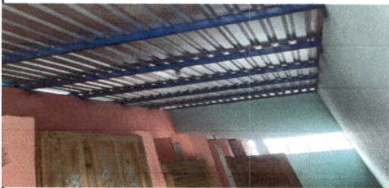
Foto 3: mantenimiento de estructura de metal baños
